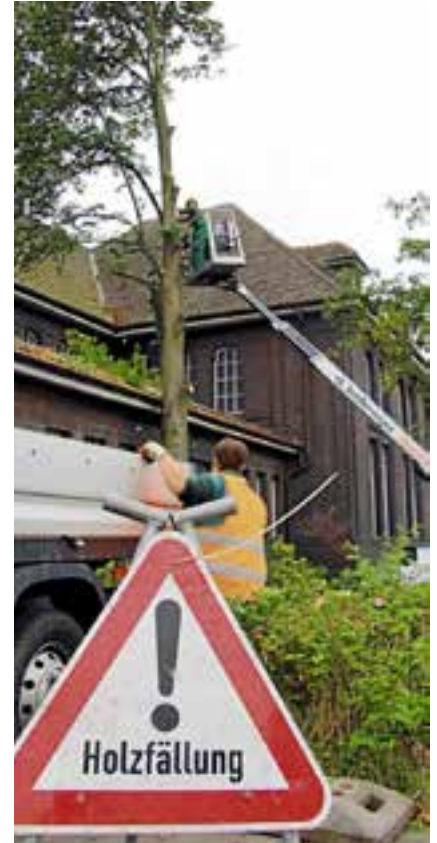
Die Bäume, die zu nahe am Gebäude stehen, werden durch die Firma Inklusia gefällt.
