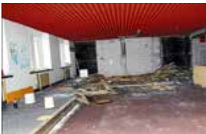
Das ehemalige Bistro ist weitgehend vom Bauschutt befreit, auch die Heizkörper sind inzwischen abmontiert. Als nächstes sollen die abgehängten Decken entfernt werden.
